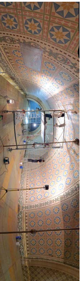
Vue panoramique de la partie supérieure de la nef de la Grande synagogue de Lausanne, en cours de nettoyage des peintures murales, travaux entrepris en 2015.
