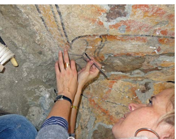
Le nettoyage fin de la surface peinte au scalpel.
