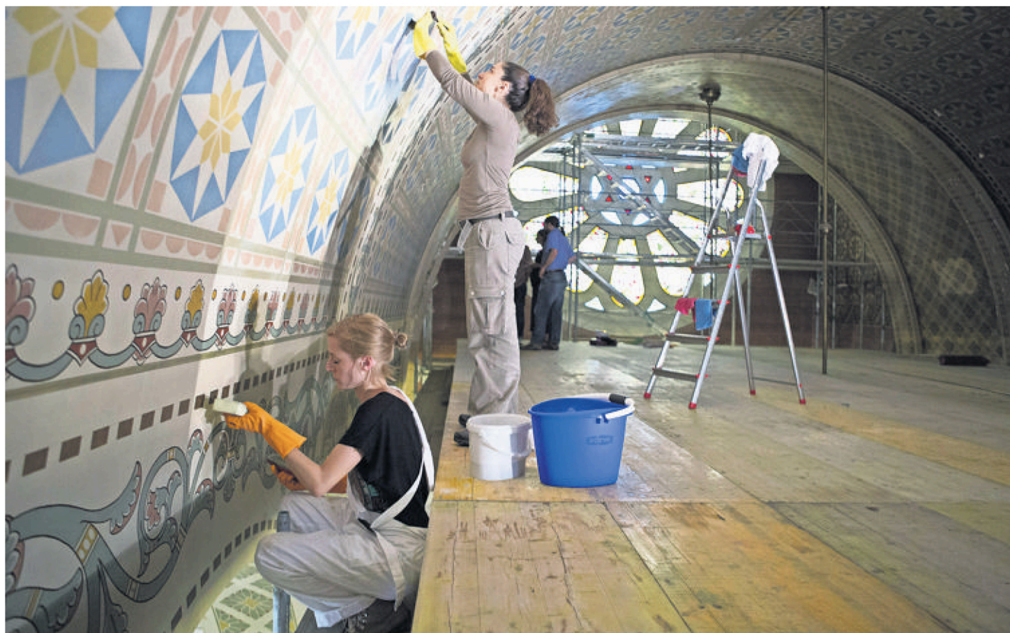
La voûte culmine à 15 mètres de hauteur et est richement décorée. Le nettoyage se fait à la brosse et à l'éponge.
