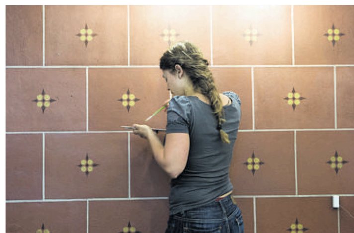
Les motifs endommagés sont refaits à la main.
