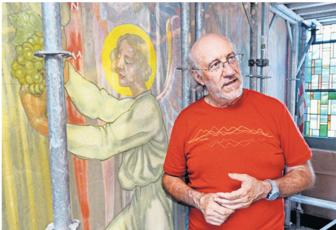
Derib a visité le chantier de la restauration des peintures murales du temple de Clarens, réalisées par son père en 1937. Il a reconnu les traits de sa mère dans le dessin d'un ange. CHANTAL DERVEY
