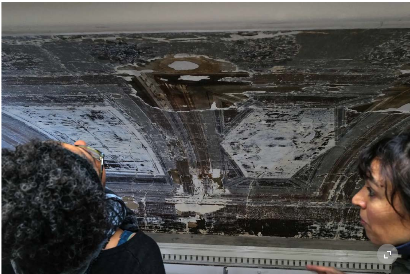
Les travaux de mise au jour des décorations dans la Salle Saint-Ours du Palais de l'Athénée. STEEVE IUNCKER-GOMEZ
